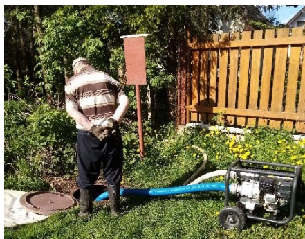
Hasiči so svojou technikou pomohli aj pri oprave poruchy na obecnej kanalizácii
