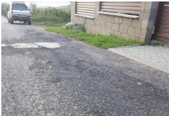
Vysypanie výtlkov na ceste do Beňadikovej
